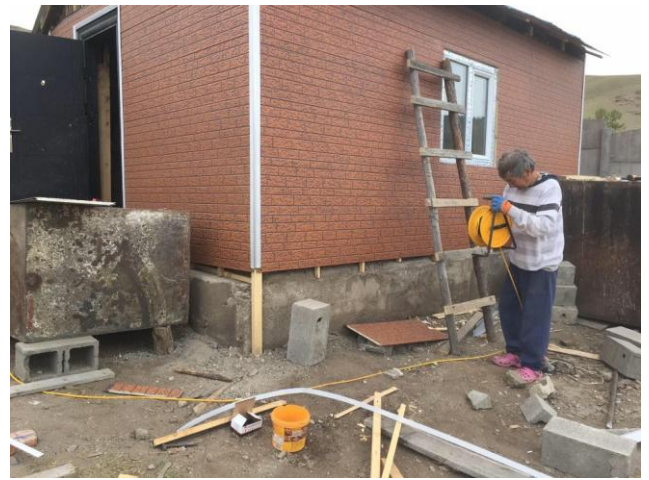
Construction de la protection du puit autour du nouveau moteur
